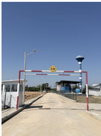
รูปที่ 2-24 การติดตั้งอุปกรณ์ควบคุมความสูง ของรถบรรทุก
