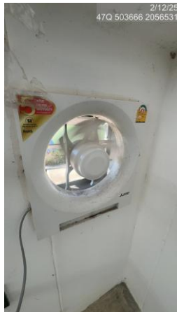
รูปที่ 2-5 ระบบดูดอากาศเฉพาะที่ในบริเวณที่มีการใช้งาน สารเคมี
