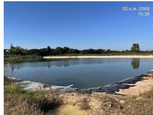
รูปที่ 2-10 ป่อเก็บน้ำเสียสำรอง
