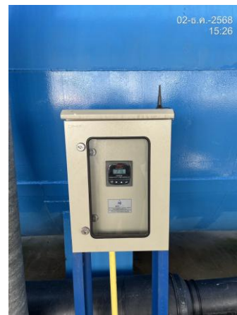
รูปที่ 2-19 ติดตั้งเครื่อง Conductivity Meter Online บริเวณระบบผลิตน้ำประปาแบบเคลื่อนย้ายได้
